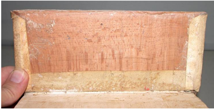
ill. n° 22 : ais d'œuvre après dépose de la garde contre collée
