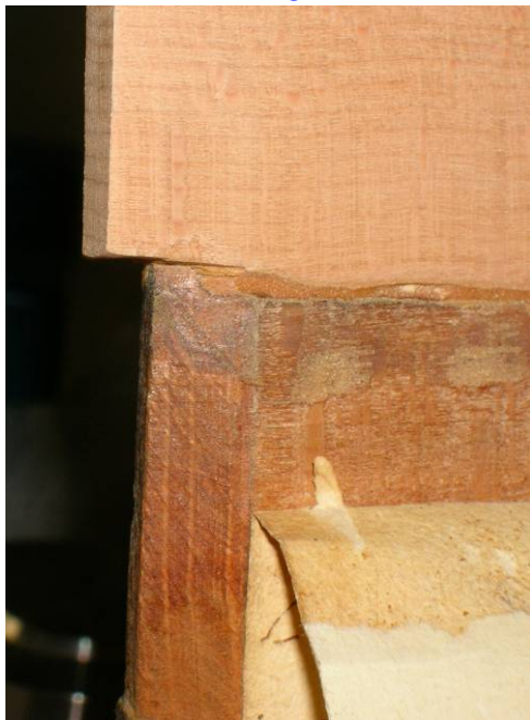
ill. n° 26 : détail du collage en bord à bord en suivant le contour de l'ais d'œuvre
